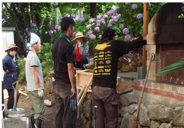
説明 新石窯築造 作業風景
