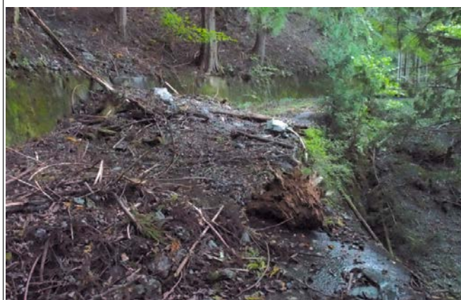
説明 コースへ土砂が押し出した
