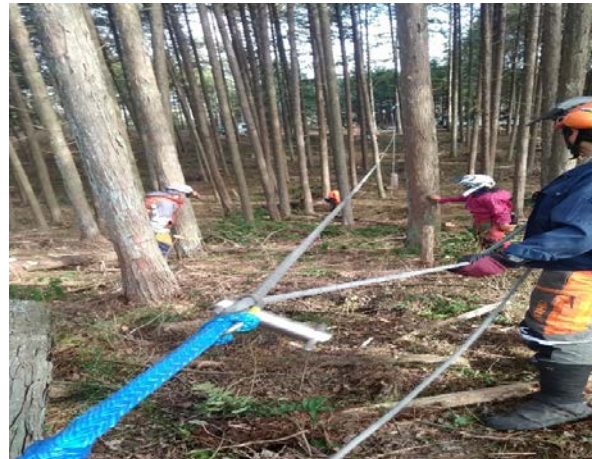
説明 安全な搬出作業確保のための架線制御器具購入
